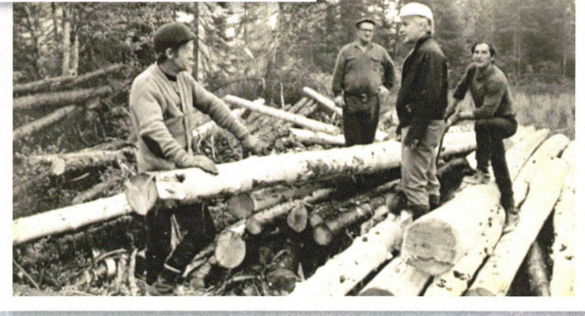
Construction du chemin pour le parc des Monts-Valin
