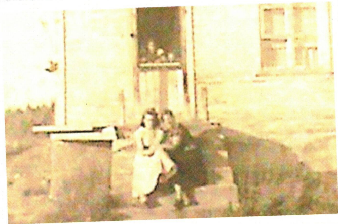
Son père et sa mère assis sur les escaliers de leur maison, anciennement l'école du Rang Saint-François
