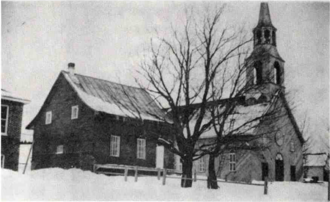
36. La deuxième église, construite en 1943 (la brique n'était pas encore posée). À côté, la sacristie détachée de la première église, démolie en 192, et qui servira de logement aux Soeurs du Bon Conseil. (Collection Marie-Rose-Tremblay).
