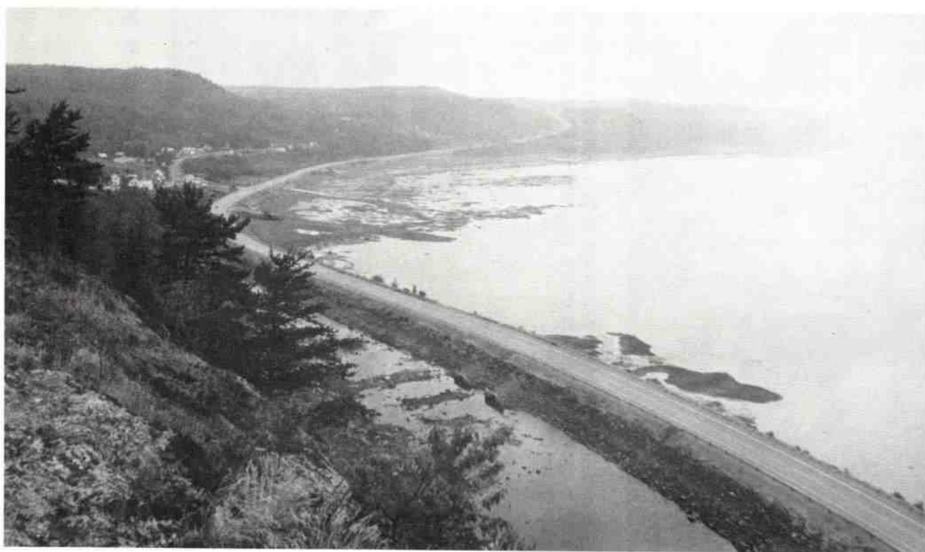
46. La nouvelle route 172, passant par Saint-Fulgence. Vue du cap des Roches (Photo Julien Caron).
