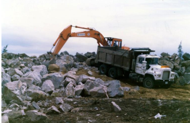
Construction de la Tourelle 1988
