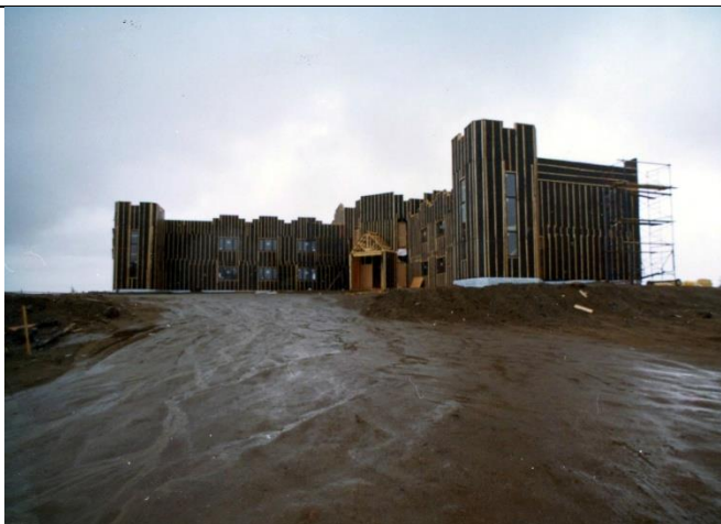
Construction de la Tourelle 1988
