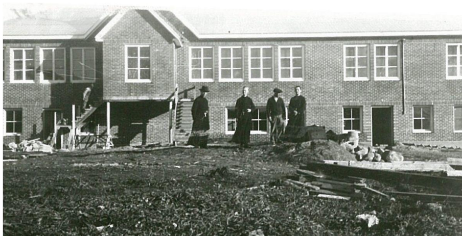
École en construction - 1947
