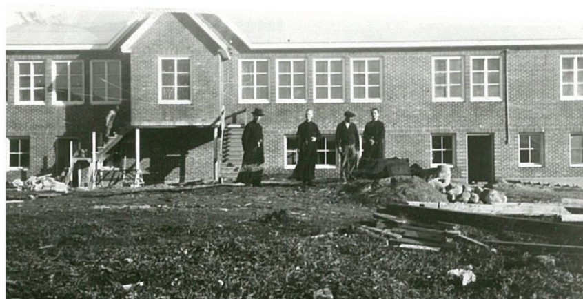
L'école en construction - 1947
